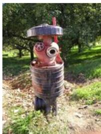
Die Schwergängigkeit ist bei älteren Überflurhydranten mit oder ohne Fallmantel das Hauptproblem. Diese bauen wir auf moderne Gleit- oder Kugellagertechnik um. Hiermit kann das Drehmoment beim Öffnen oder Schließen um bis zu 90 % gesenkt werden.
