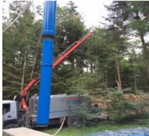
Nach dem Ausbau der Steigleitung DN150 inkl. Saugstromsteuerung erfolgte jeweils eine Kamerabefahrung. Diese zeigte eine bis auf einige Scheuerstellen (ursächlich: anliegende Flansche der Steigleitung) weitestgehend intakte Brunnenverrohrung und nahezu keine Verockerungen. In den Filterschlitzten war jedoch in den Brunnen ragendes Filterkiesunterkorn sowie Feinsand zu erkennen. Im Brunnensumpf hatte sich jeweils eine feinsandige Auflandung gebildet.
