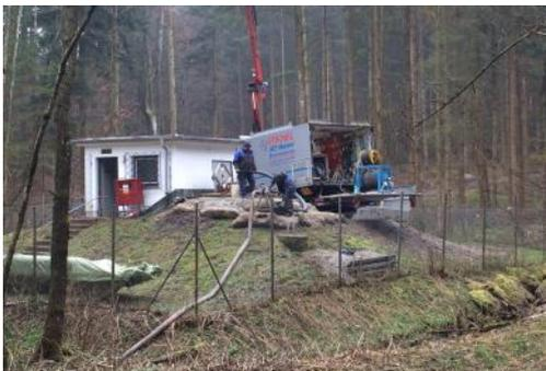
Der Brunnen 3 zeigte nach der **JET Master®** Nachentwicklung und Abschlusspumpversuch eine um 59% höhere spezifische Ergiebigkeit bei gut 2 m weniger Absenkung im Vergleich zur Neubohrung. Auf den Wiedereinbau der Saugstromsteuerung wurde verzichtet. Um die Scheuerstellen im Ausbau nicht weiter zu vertiefen, wurden die Steigleitungen mit Rollenzentrierungen versehen. Nach Probenahme und Vorliegen der einwandfreien mikrobiologischen Befunde konnten die Brunnen wieder ans Netz gehen.
