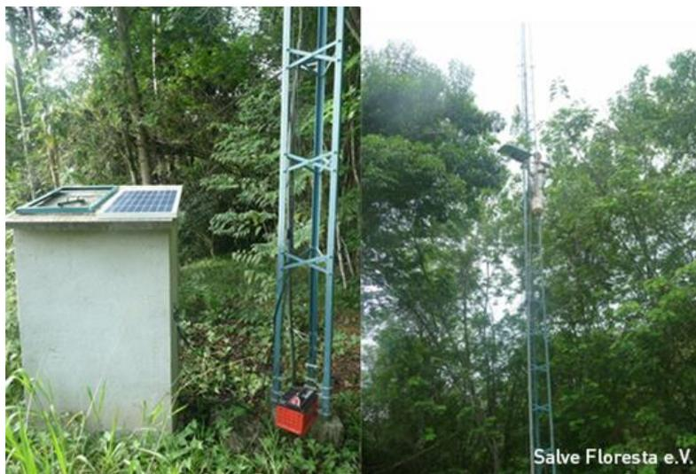
Auch in Deutschland sind solche kleinen Insulanlagen in Betrieb, z.B. auf der Autobahn für die digitalen Verkehrszeichen, in netzfernen Gebieten für Messgeräte oder kleine/mittlere Pumpen, die durch die Photovoltaik mit Strom versorgt werden.
