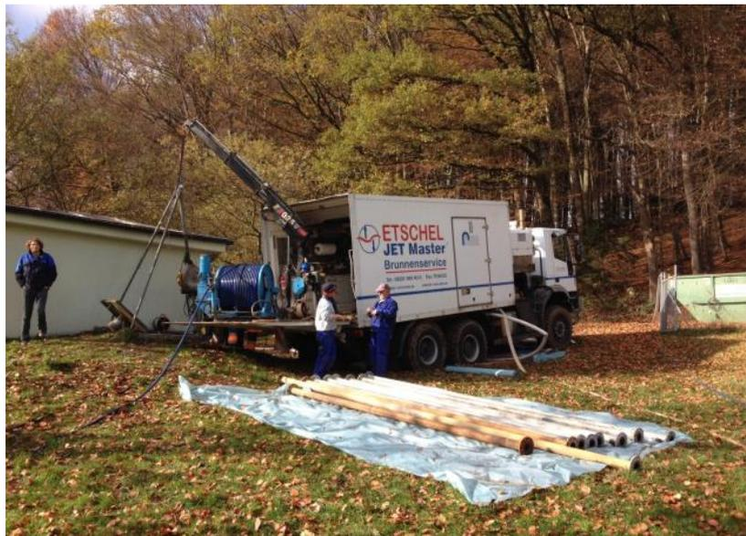
Die mechanische Regenerierung im DWI Verfahren mit dem JET Master® und nachfolgende Intensiventsandung reinigte den Brunnen tiefenwirksam bis hin zur Bohrlochwand. Bei der zum Ende der Maßnahme folgenden TV Befahrung waren die Filterschlitzte weitgehend frei. Nur vereinzelt konnten noch durch Schwebeteilchen belegte, jedoch nicht verstopfte Schlitzte festgestellt werden. Die Auflandung wurde soweit technisch möglich entfernt.
